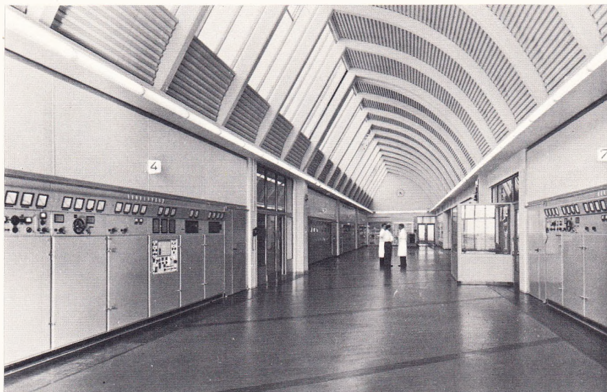
Bild 7. Senderhalle in Jülich mit 10 Sendern mit je 100 kW Leistung (Telefunken). Neun davon sind täglich 24 Stunden in Betrieb, der zehnte steht in Reserve
